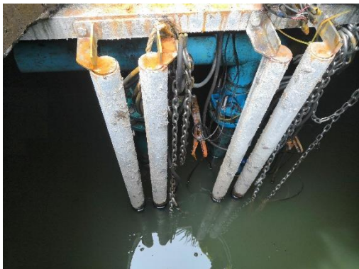
ปั๊มสูบน้ำเสียที่ผ่านการบำบัดแล้วมารดน้ำต้นไม้
